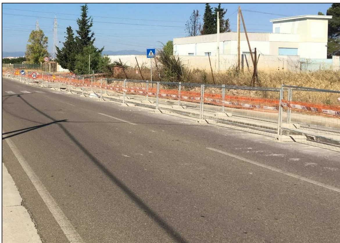
Figura 23 Esempio di segregazione aree di cantiere
