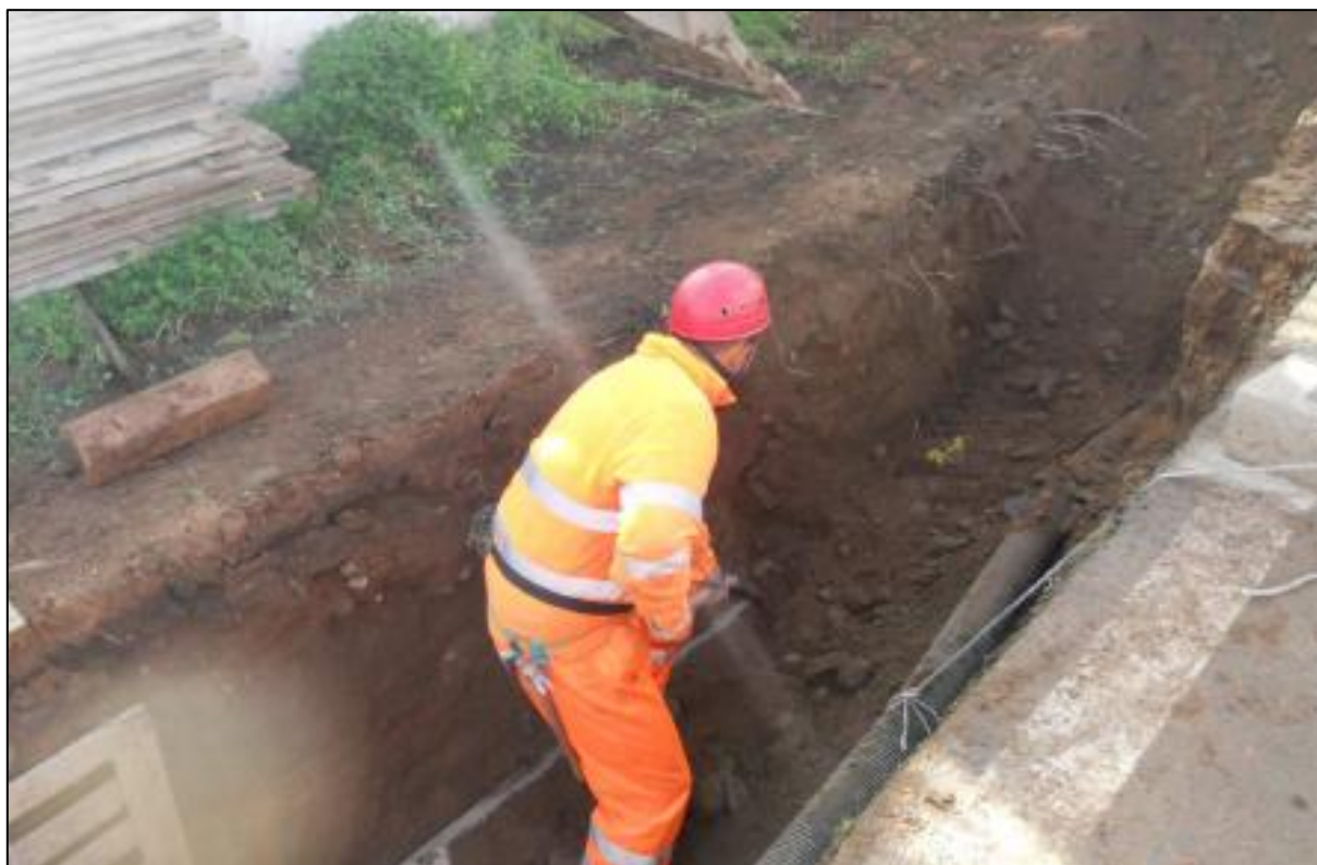
Figura 28 Scavo manuale per linea interrata
