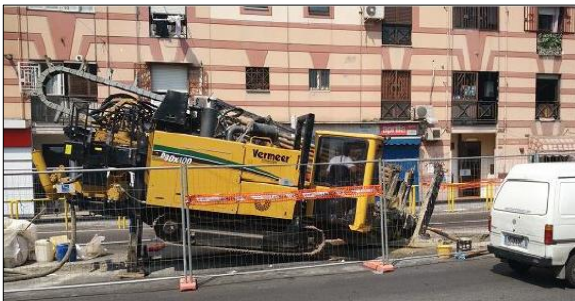
Figura 9 Macchina operatrice trivellazione teleguidata (HDD)
