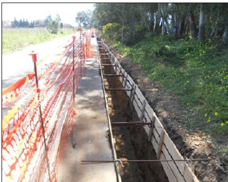
Figura 32 Esempio sbadacchiatura pareti di scavo in trincea
