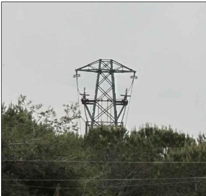
Figura 16 Sostegno di transizione aereo/cavo
